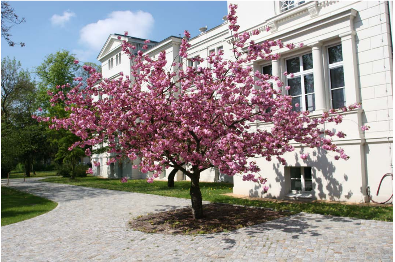
Villa Ingeheim (Rückseite), Dienstsitz des Zentrums für Militärgeschichte und Sozialwissenschaften der Bundeswehr
